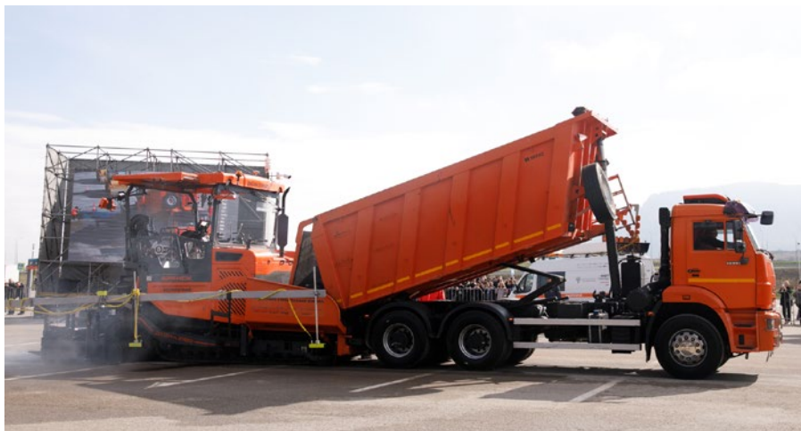
Демонстрационная беспилотная укладка асфальтобетонного покрытия на Выставке «Дорога 2025»
