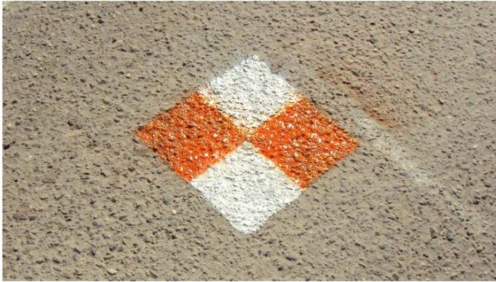
*Рис. 1. Внешний вид контрольной точки на проезжей части*
