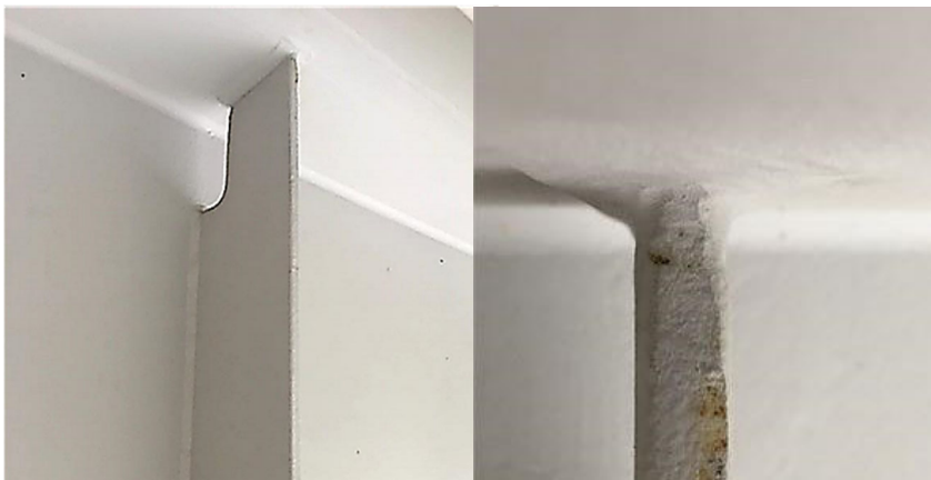
Рис. 22. Изображение узла без видимой усталостной трещины
