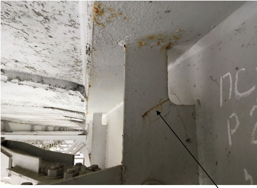
Трещина типа 4
