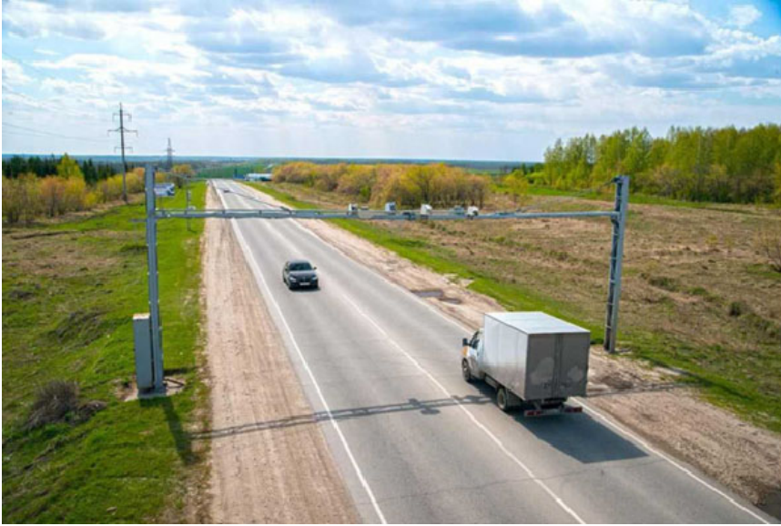
Рис. 4. Пункт WIM на автомобильной дороге Новосибирск – Колывань – Томск (у села Колывань)
