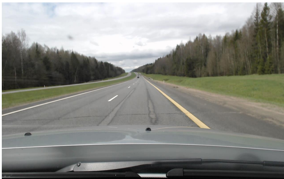
Рис. 1. Опытный участок автомобильной дороги М9 «Балтия», расположенный на 103 км
