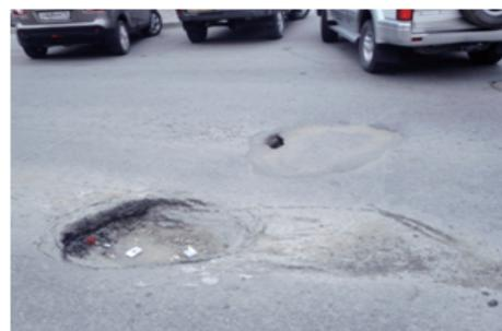
*Рис. 4 б. Участок автомобильной дороги с просадкой покрытия*
