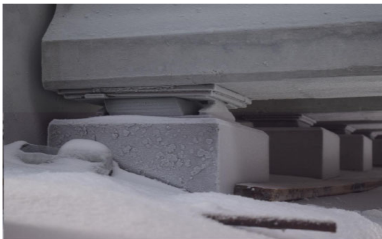
Рис. 2. Предельный сдвиг резиновой опорной части
