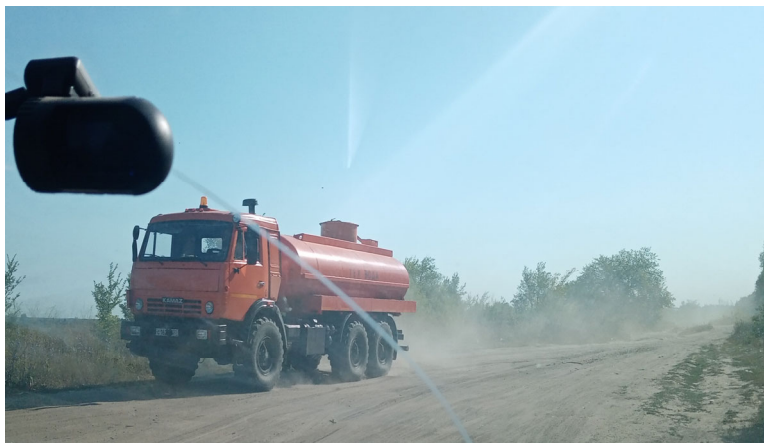
Рис. 4. Проведение обработки дорожного покрытия обеспыливающим раствором при помощи КДМ с поливомоечным оборудованием
