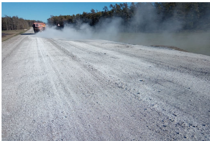
Рис. 3. Обработка пылящих покрытий на автомобильной дороге к г. Якутску (ФКУ Упрдор «Вилуй»)
