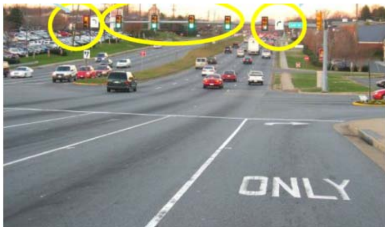
Рис. 12. Улучшение видимости сигналов на РП за счет размещения светофоров за перекрестком над каждой полосой проезжей части
