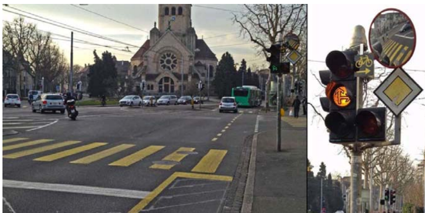
Рис. 10. Применение дорожного зеркала на РП
