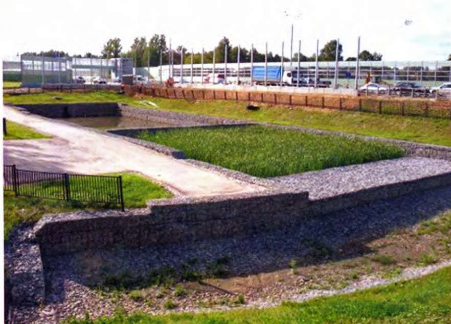
Рис. 3. Очистные сооружения с использованием габионов
