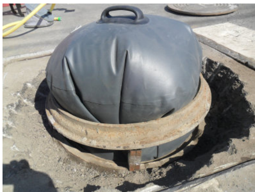
Рис. 8. Монтаж резиновой камеры в горловине колодца
