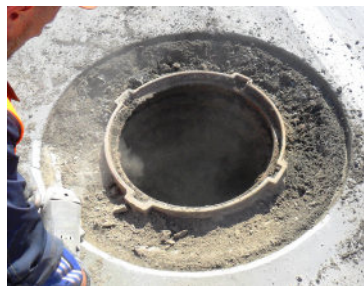
Рис. 5. Технологическая вырубка материала дорожного покрытия: а – квадратная форма; б – круглая форма
