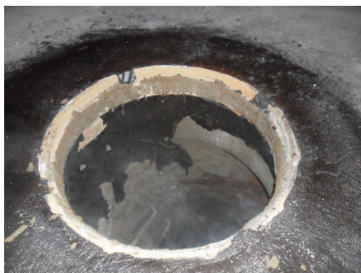
Рис. 10. Отремонтированный участок дороги в месте расположения канализационного колодца: а – без люка; б – с люком
