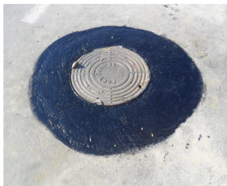
Рис. 10. Отремонтированный участок дороги в месте расположения канализационного колодца: а – без люка; б – с люком
