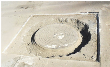
Рис. 5. Технологическая вырубка материала дорожного покрытия: а – квадратная форма; б – круглая форма
