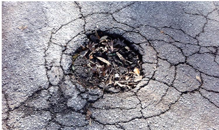
*Рис. 3. Ухудшение состояния дорожного асфальтобетонного покрытия вследствие образования выбоины*
