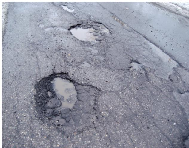
*Рис. 2. Развитие выбоин в процессе эксплуатации автомобильной дороги*
