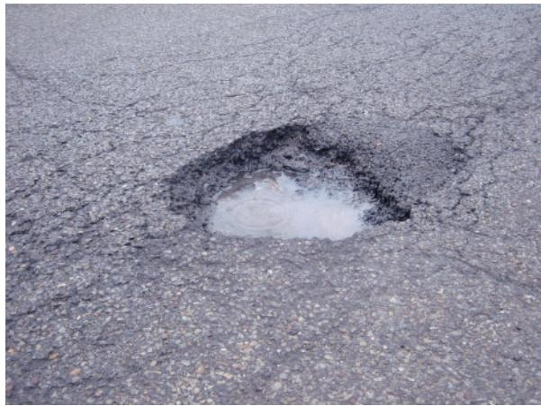
*Рис. 1. Образование выбоины на дорожном асфальтобетонном покрытии*
