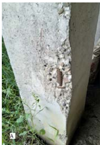
Рис. 5. Оголение и коррозия арматуры на сборной железобетонной свае (А) и консоли монолитной железобетонной насадки (Б) береговой опоры моста № 4
