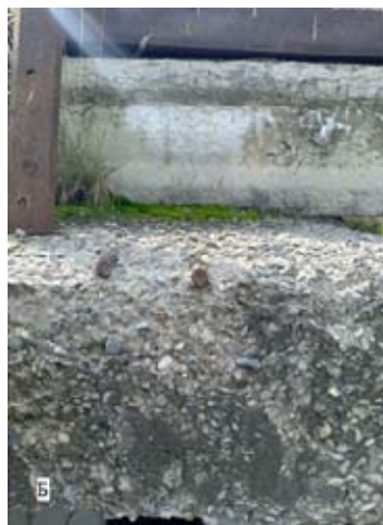
Рис. 5. Оголение и коррозия арматуры на сборной железобетонной свае (А) и консоли монолитной железобетонной насадки (Б) береговой опоры моста № 4
