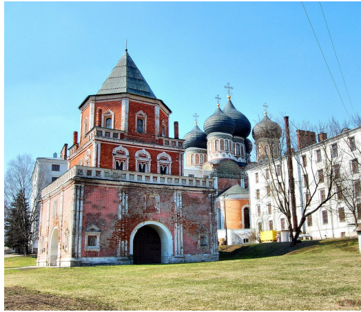
Рис. 1. Мостовая башня XVII века, Измайловский комплекс, г. Москва (в процессе текущего ремонта)
