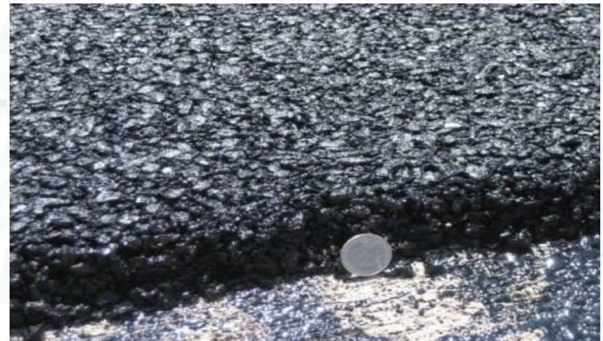
Тонкослойный асфальт с добавлением резиновой крошки
