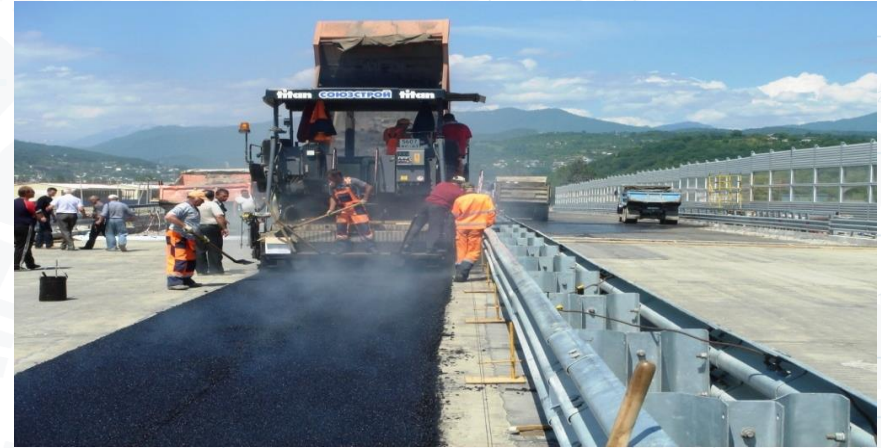
Асфальтовое покрытие на мостах
