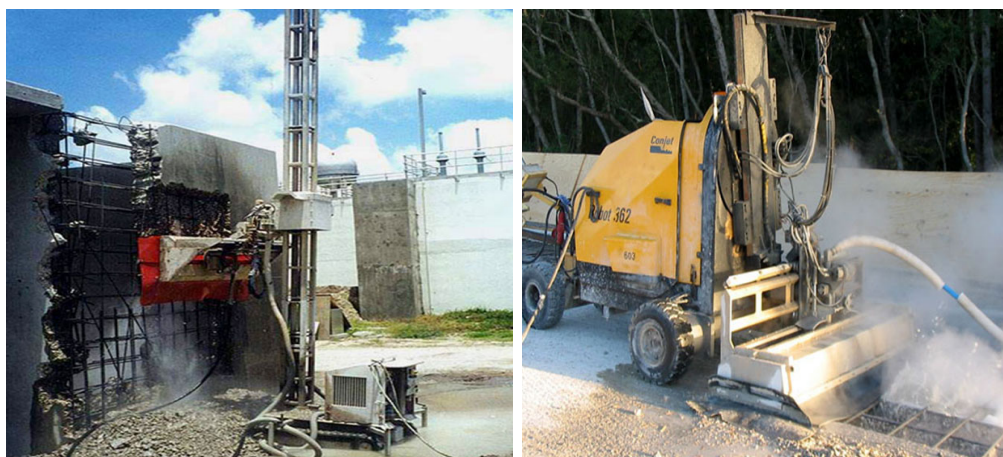
Рис. 1. Применение гидроустановок высокого давления для удаления поврежденных слоев цементобетонных покрытий
