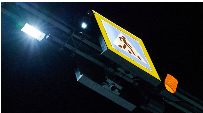
Рис. 2. Внешний вид светодиодного дорожного знака 5.19.2, проектора, светодиодного светильника и светофора Т7, установленных на П-образной опоре
