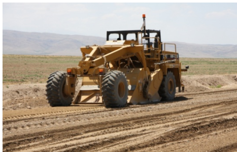
Рис. 2. Перемешивание цементогрунтовой смеси после внесения водного раствора «Дорзин» самоходным грунтосмесителем
