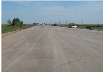
Рис. 1. Готовое основание из укатываемого золобетона на а/д «Астана-Щучинск» км 7-57 (подрядчик – «К-Дорстрой»; научно-методическое сопровождение – ТОО КазНИиПИ «Дортранс»)
