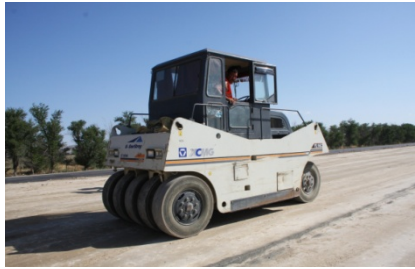
Рис. 3. Уплотнение цементогрунта катками на пневмоходу на участке а/д «Алматы – Ташкент – Термез» (подрядчик – фирма «К-Дорстрой»)
