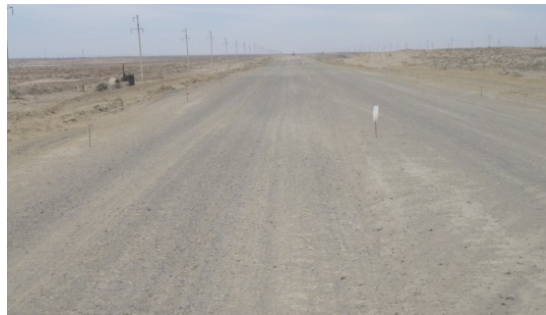
Рис. 6. Готовый участок дороги со стабилизированным грунтом земляного полотна, а/д «Граница РФ (на Самару) – Шымкент», Кызылординская область (подрядчик – фирма АО «Салини Коструттори С.П.А.»)
