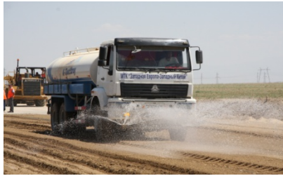
Рис. 4. Внесение водного раствора Дорзин в грунтовую смесь. Реконструкция а/д «Алматы – Ташкент – Термез» в дорогу 1-Б категории (подрядчик – фирма «К-Дорстрой»)
