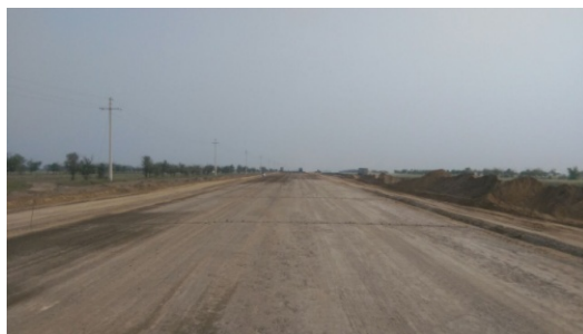
Рис. 7. Участок завершеного строительства а/д «Павлодар – Семей» на шламобетонном основании, с нарезкой швов с шагом 10 пог. м. (подрядчик – ТОО «Павлодар Жолдары»; научно-методическое сопровождение – ТОО КазНИИПИ «Дортранс»)
