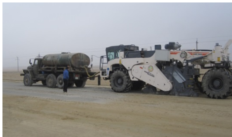
Рис. 5. Фрезерование ресайклером, смешение грунта с цементом с одновременной подачей водного раствора с «Дорзином» (подрядчик – фирма АО «Салини Коструттори С.П.А.»)
