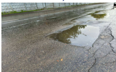
Рис. 5. Дефекты дорожного покрытия (фотоснимок авторов):
