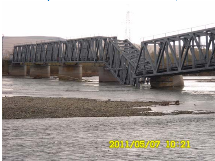
Рис. 2. Разрушение тела опоры (мост через р. Енисей на участке автомобильной дороги Р-257 «Енисей», км 44+500)
