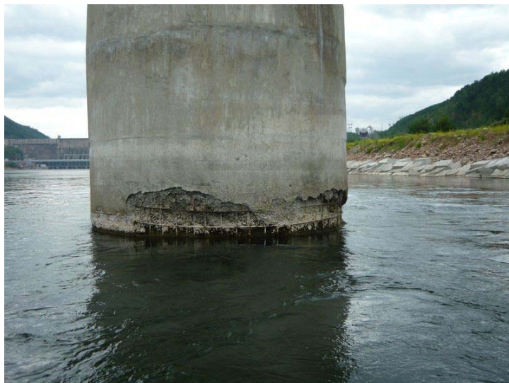
Рис. 2. Разрушение тела опоры (мост через р. Енисей на участке автомобильной дороги Р-257 «Енисей», км 44+500)
