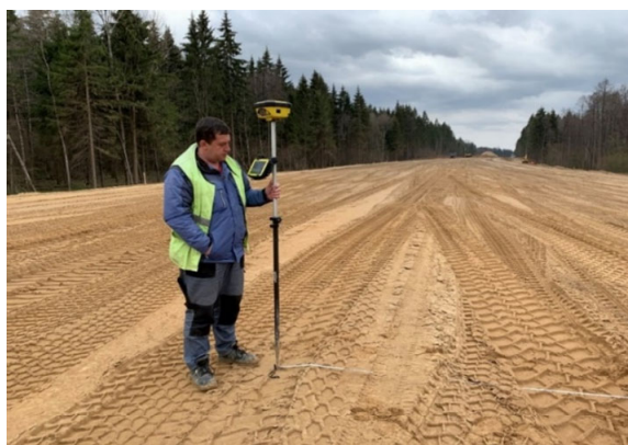
Рис. 5. Определение высотных отметок земляного полотна при помощи ГНСС-оборудования
