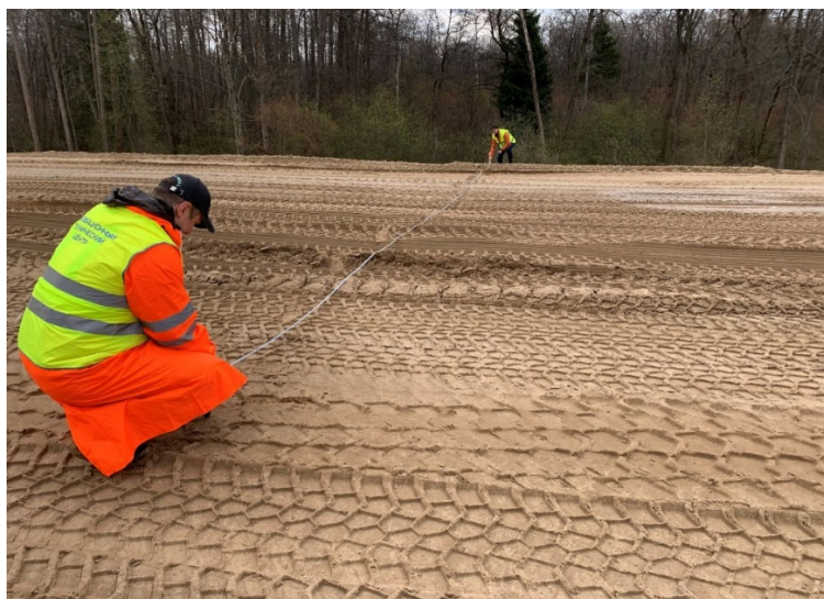
Рис. 1. Определение ширины земляного полотна, согласно требованиям СП 78.13330.2012
