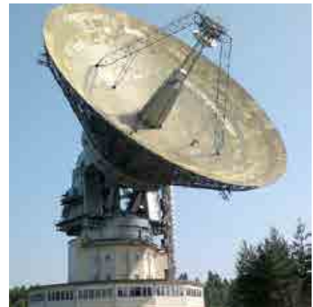
Рисунок 6. Наземный многоцелевой радиотелескоп ОКБ МЭИ диаметром ЗРТ-64 на базе антенной системы ТНА-1500К диаметром 64 м микроволнового диапазона в г. Калязине был признан лучшим в мире по ряду параметров и включен вместе с радиотелескопом ТНА-1500 ЦДКС «Медвежий озера» в программу «ЕКЗОМАРС»
