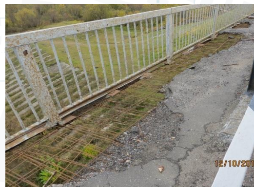
Эрозия железобетона от воздействия стоков и плохой защиты
