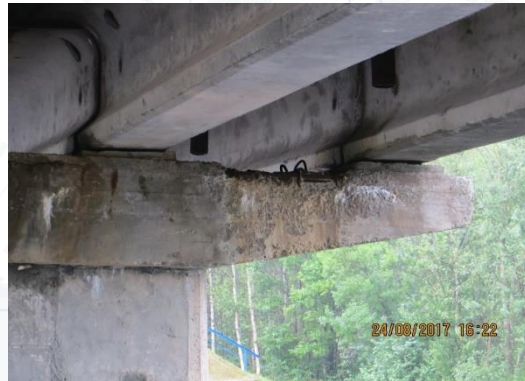
Дефекты несущих конструкций из-за протечек деф. швов
