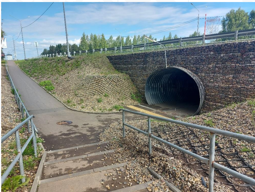
Устройство подземного пешеходного перехода вместо надземного
