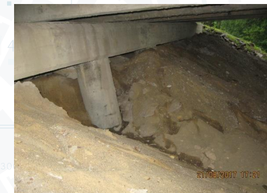
Дефекты насыпей и конусов из-за дисфункции водоотвода
