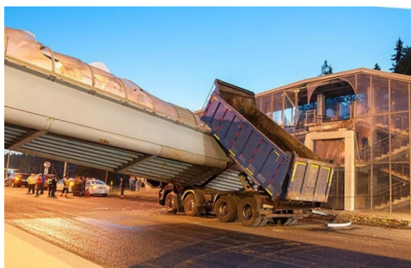
Рис. 8. Аварийное разрушение пешеходного моста на участке автомобильной дороги М-10 (1 июля 2016 г., Солнечногорский район, Московская область)
