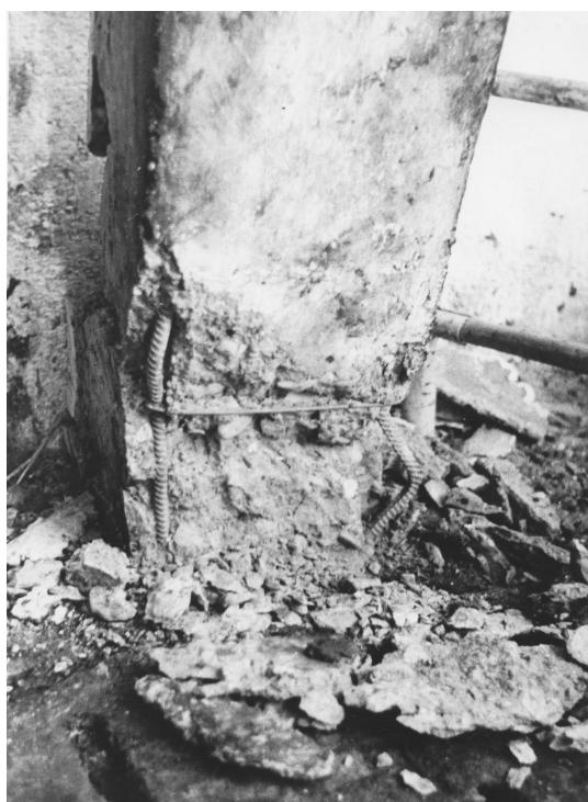
*Рис. 2. Разрушение колонны в процессе эксплуатации
