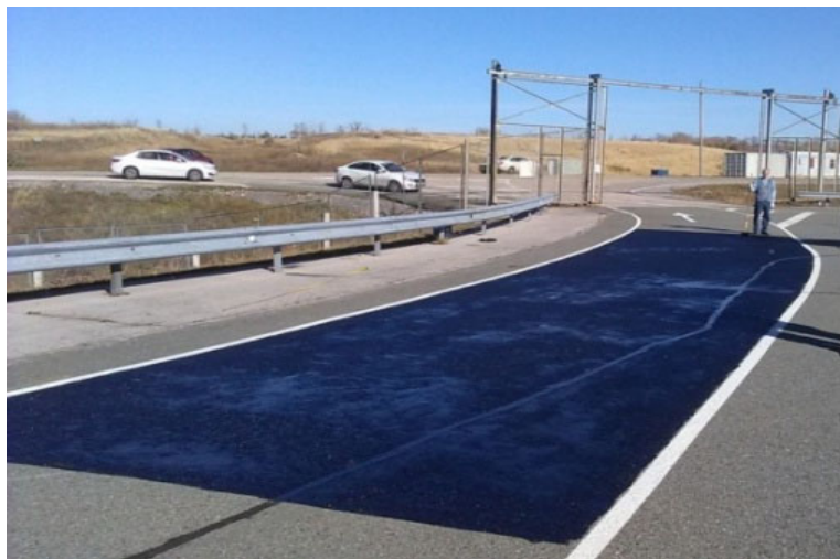
Рис. 6. Общий вид участка автополигона, обработанного пропиточным составом «Спрут»
