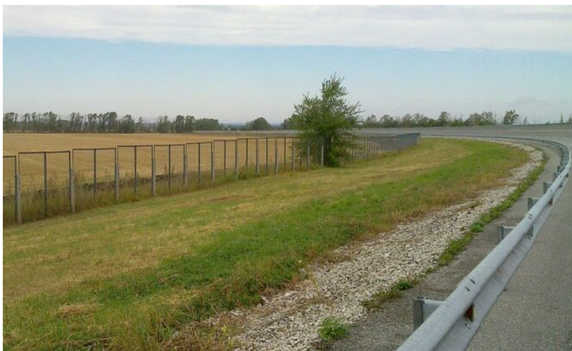
Рис. 5. Общий вид заборного и удерживающего ограждений
