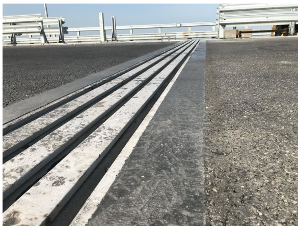
Рис. 1. Полимербетонное покрытие пришовной зоны деформационного шва путепровода
