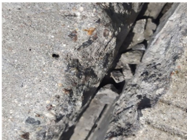
Рис. 6. Расклинивание шва
