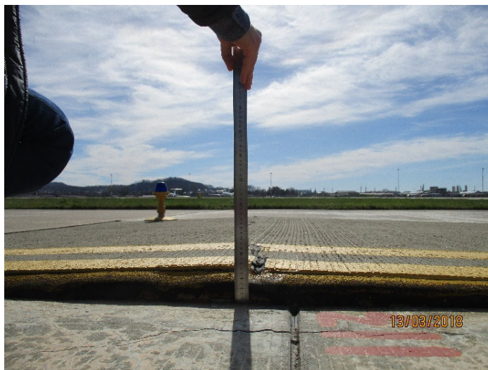
Рис. 3. Выпуклый изгиб плиты
