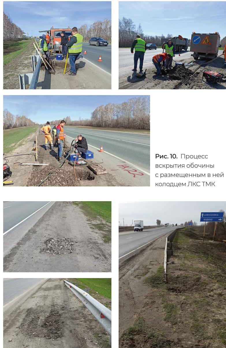
**Рис. 10.** Процесс вскрытия обочины с размещенным в ней колодцем ЛКС ТМК
