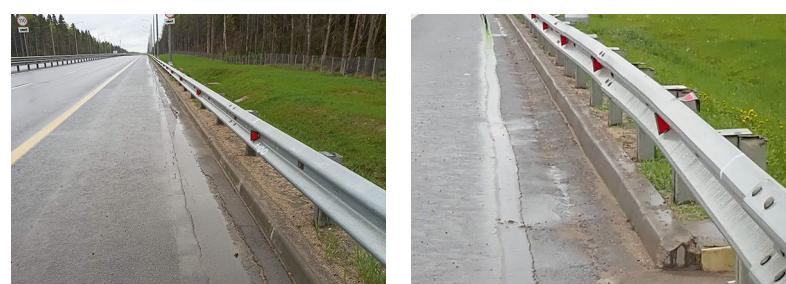
Рис. 3. Застой воды вдоль трассы ЛКС, нарушение поверхностного водоотвода
