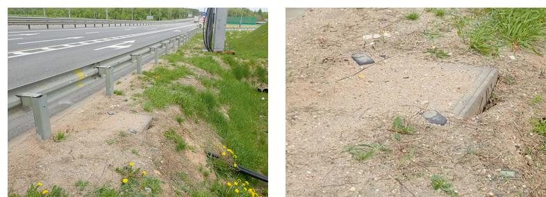
Рис. 2. Размыты земляного полотна автомобильной дороги у смотровых колодцев и вывод незакрепленной кабельной канализации через канаву
