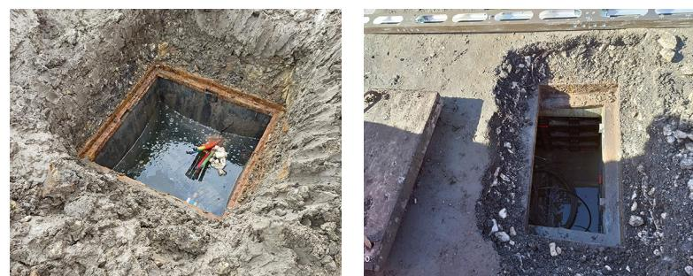
**Рис. 8.** Затопление СУ в обочине автомобильных дорог
