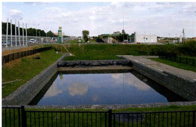
Простейшие очистные сооружения
