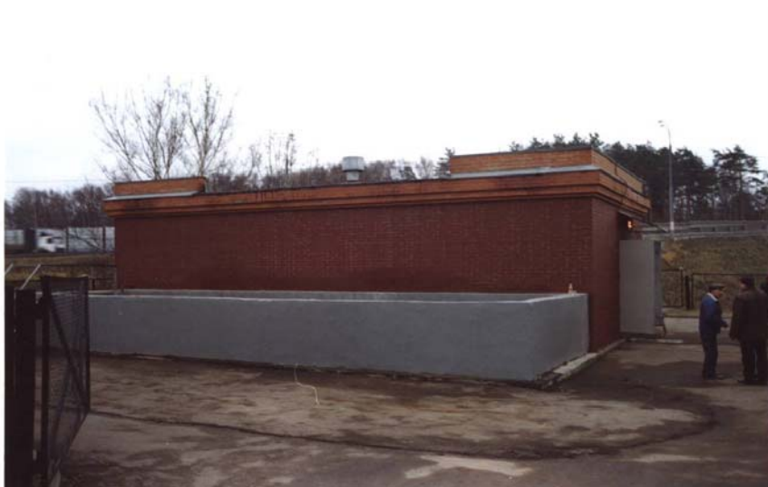
Рис. 2. Очистные сооружения индивидуального проектирования (общий вид)
