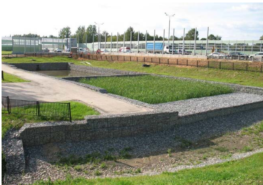
Рис. 6. Очистное сооружение каскадного типа с использованием габионов (вид сбоку), автомобильная дорога М-3 «Украина»
