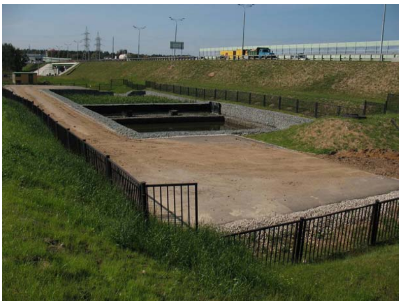
Рис. 7. Очистное сооружение каскадного типа с использованием габионов (вид сверху), автомобильная дорога М-3 «Украина»
