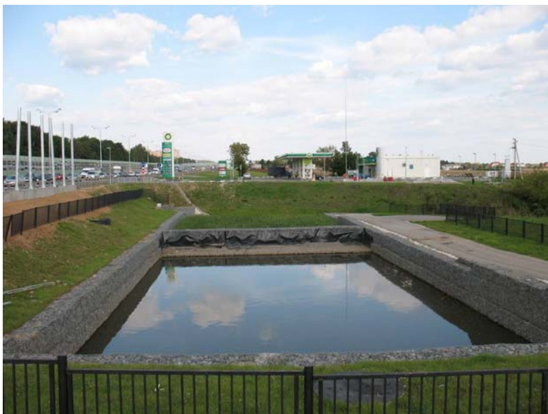
Рис. 7. Очистное сооружение каскадного типа с использованием габионов (вид сверху), автомобильная дорога М-3 «Украина»
